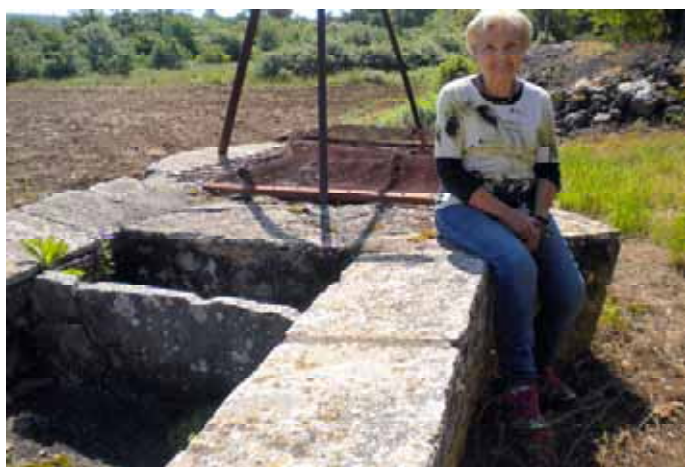
Élise au bassin des Peyres, derrière le puit
