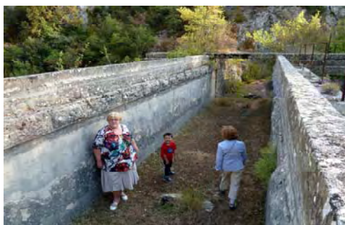
Le lit du canal sur le pont
