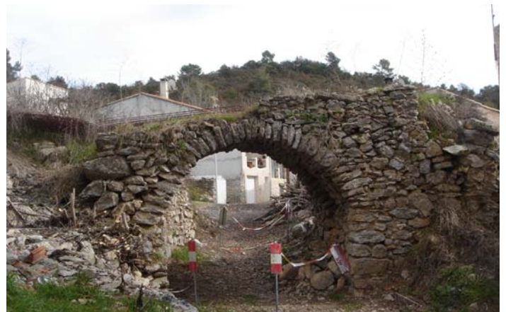
Le petit pont de Boisset
