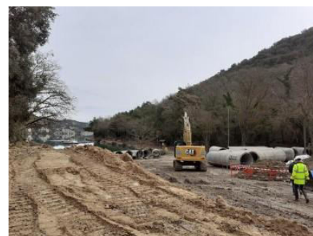
Chantier plage de Saint-Julien
