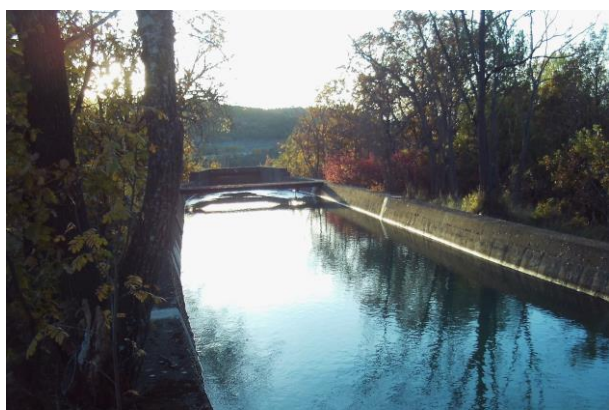
Entrée dans le siphon en acier
