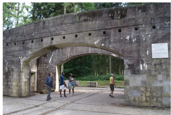
Bâtiment amagnétique du site du Val Ygot
