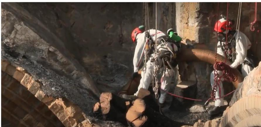
Les **cordistes** entrent en jeu pour installer des filets antichute et des bâches de protection. Il faut consolider les pignons nord et sud qui n'ont plus de charpentes pour les maintenir. Il faut consolider également avec des supports en bois les 28 arcs-boutants essentiels pour le maintien de la cathédrale. Il faudra six mois pour le faire.
